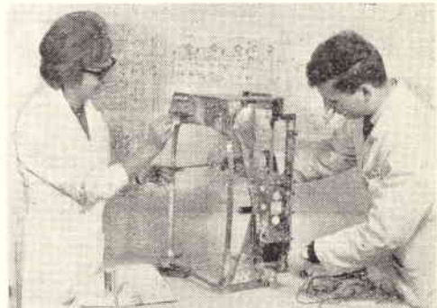
Montaggio del trasformatore
